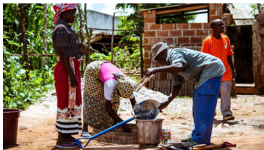
Das Projekt ORATTA unterstützte 2023 den Ausbau von Trinkwasseranlagen in Mosambik
